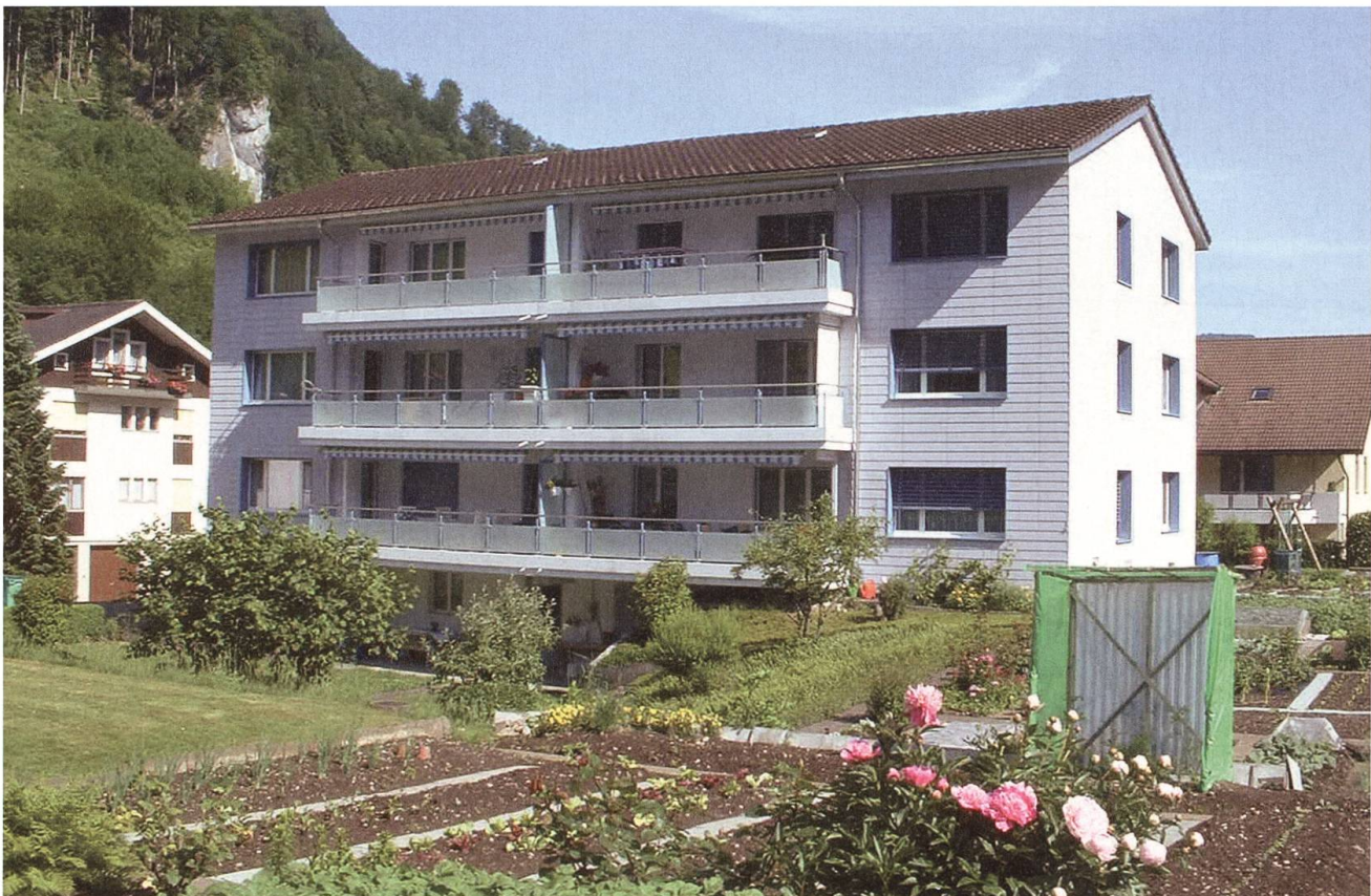
Die Mehrfamilienhäuser an der Allmendstrasse schaffen einen Wert, der über Generationen hinaus bestand hat.
