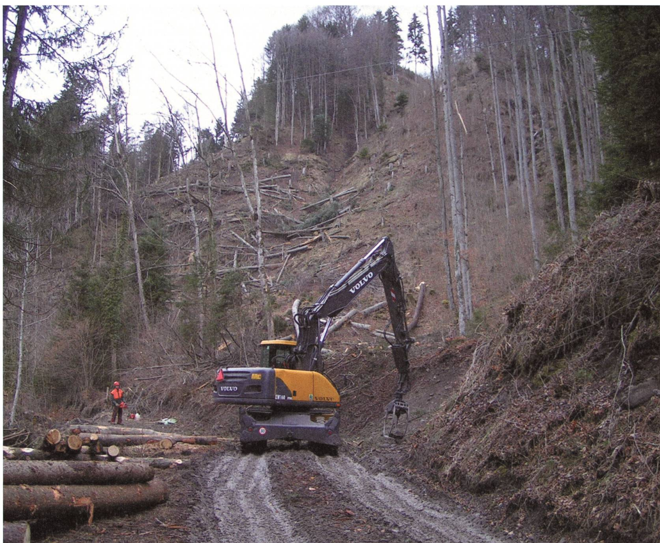
Die Uertekorporation Dallenwil investiert jährlich bis zu 100'000 Franken in die Pflege der Dallenwiler Schutzwälder.
