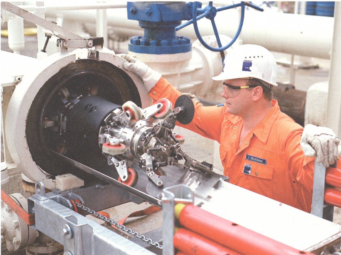
Ein Rosen-Mitarbeiter beim Einschleusen des Molchs in die Röhre.
