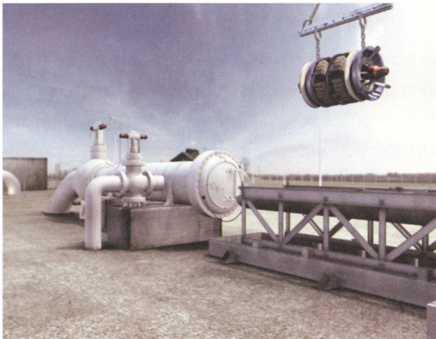
Einsatzbereiter Molch wird zur Schleuse transportiert.
