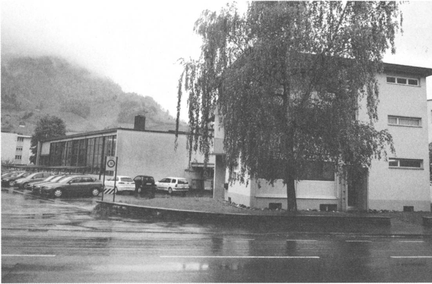
11.5. Werkstatt und Wohnhaus der Schilterfabrik in Stans.
