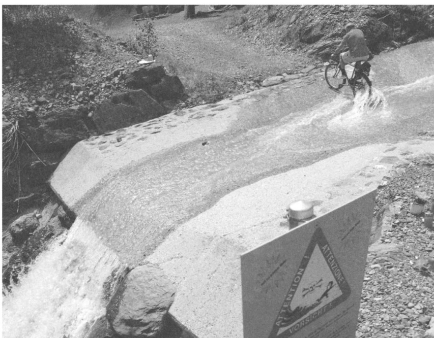
17.7. Bei der Flut am Gerlibach ereignete sich das Unglück.
