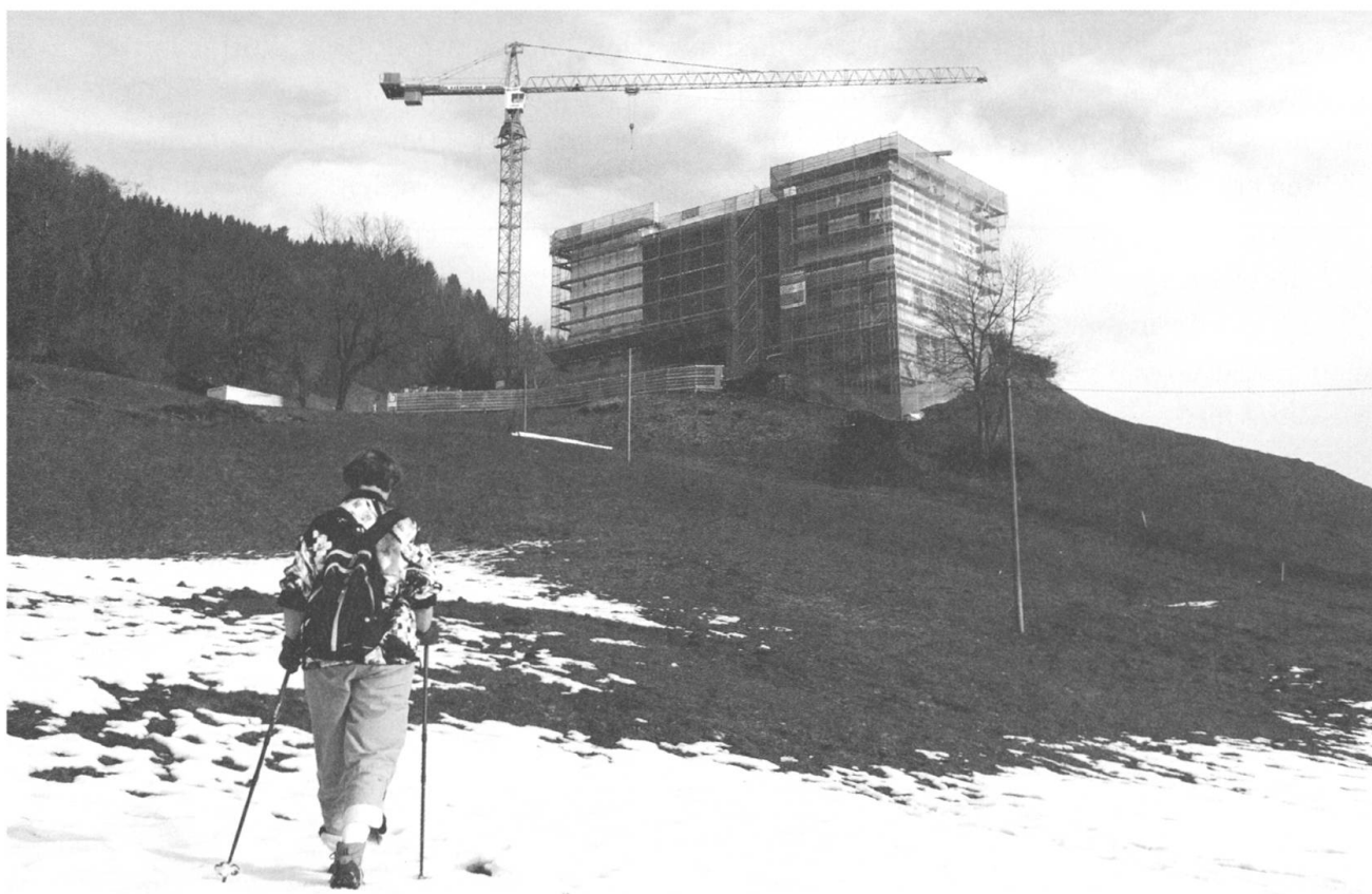
6.2. Hotel Honegg, Teil des Bürgenstock-Resorts: Seit Herbst 2008 laufen die Umbauarbeiten.
