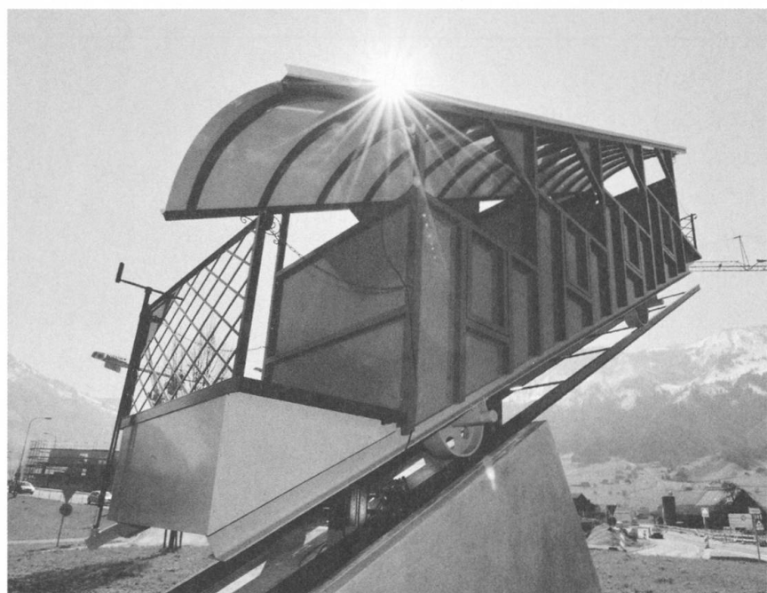
21.3. Nachgebauter Bahnwagen der Stanserhorn-Bahn im Kreisel.
