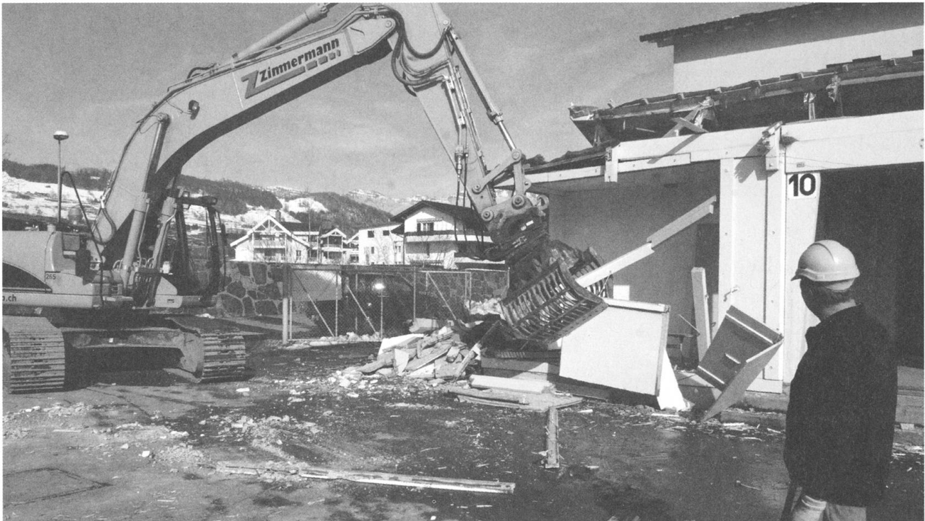
26.3. Zwölf der 14 Militärbaracken des Aadörfli in Buochs wurden abgerissen.
