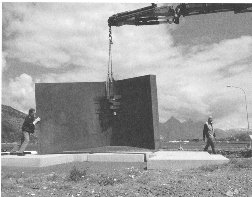
1.5. Die Eisenskulptur «Gebogene Wand» wird aufgestellt.
