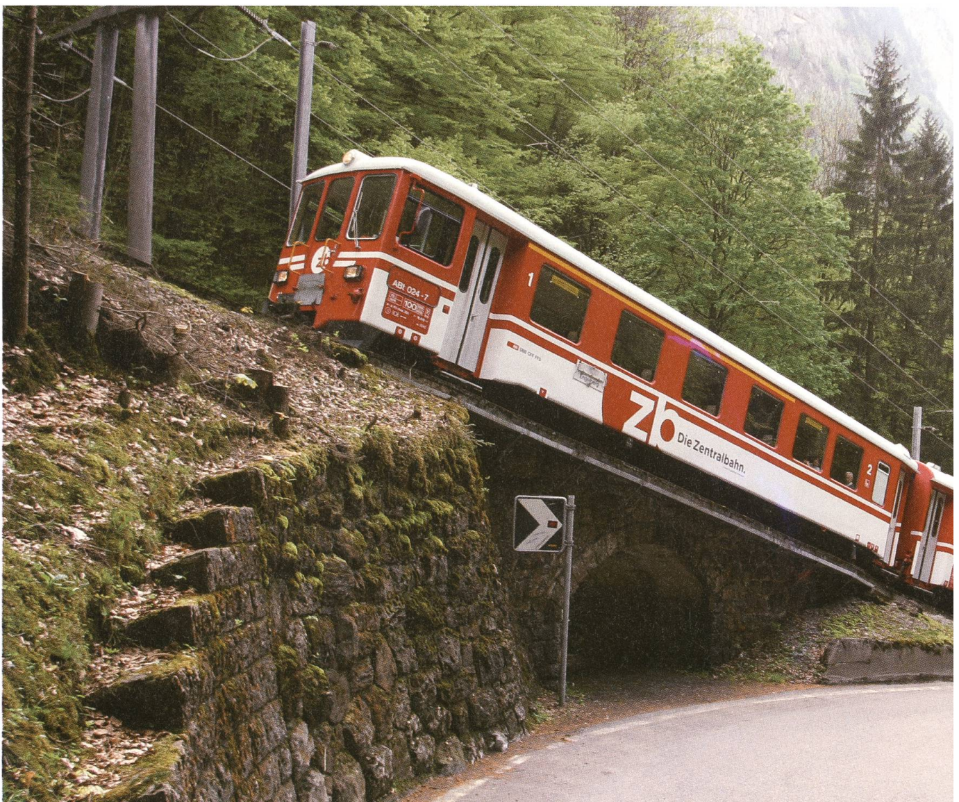
Auf dem Weg nach Engelberg hatte die Zentralbahn bisher eine enorme Steigung überwinden müssen.
