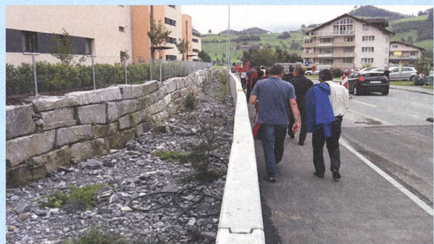
H: Die Versickerungsmulde leitet zugleich das Hochwasser weiter ins Retentionsbecken.
