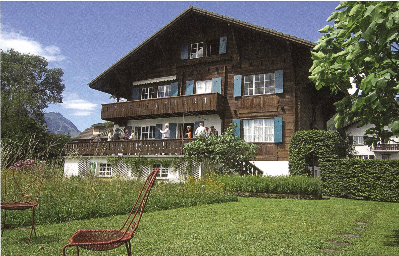
Der «Rote Nagel» wurde auch in Ennetbürgen eingeschlagen. Chalet von Moos an der Seestrasse 11.
