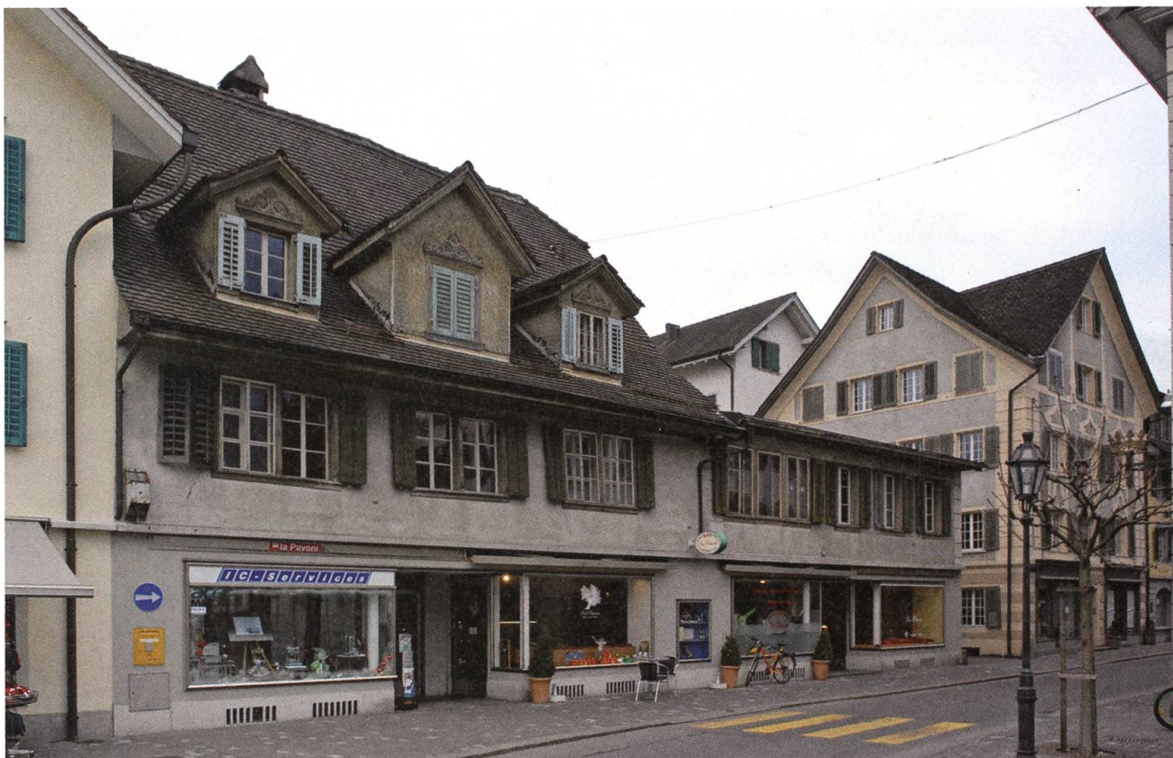
Das Wohn- und Geschäftshaus Dorfplatz 4 ist Bestandteil des geschützten Dorfplatzes von Stans.
