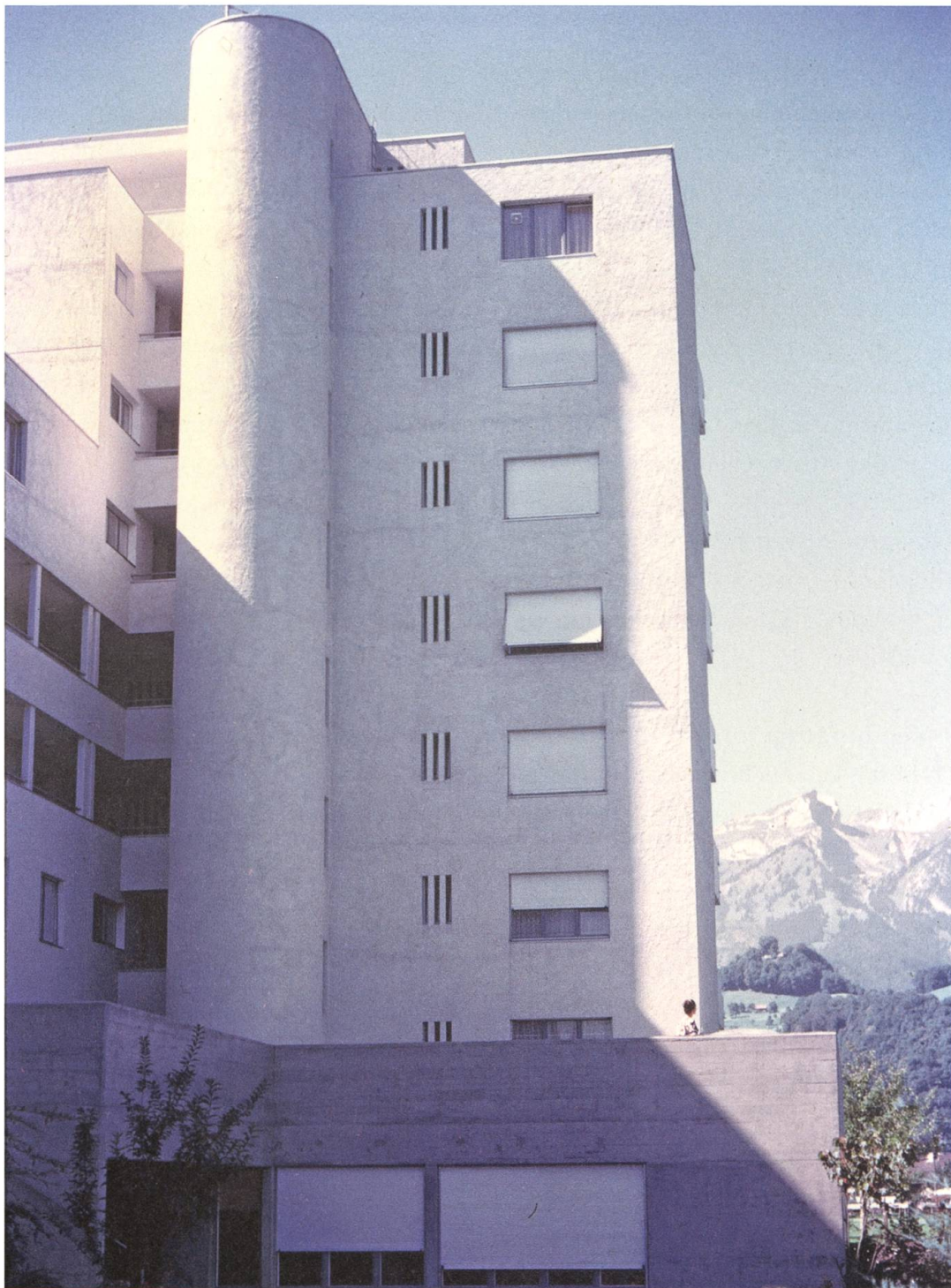
Übernahme von Motiven des Modernen Bauens: Treppenhaus im Wohnturm.
