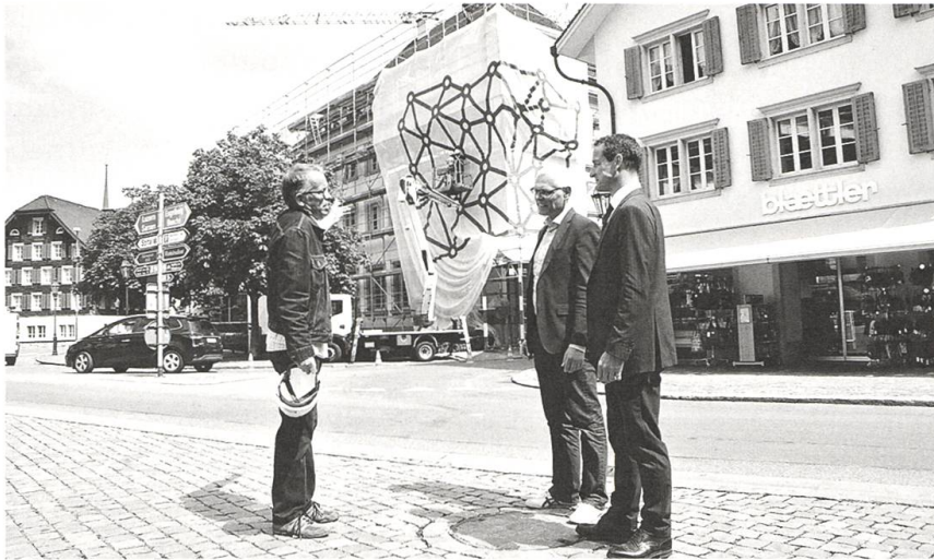
15.6. Regierungsgebäude mit gestalteter Gerüstschutzpläne während Umbau.
