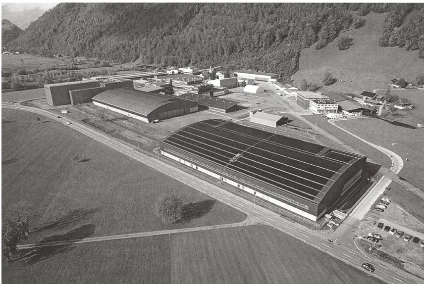
12.12. Die Solaranlage auf dem Dach der Pilatus-Produktionshalle.
