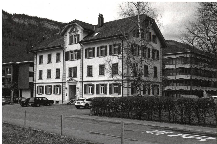
3.2. Das Haus Centro an der Weidlistrasse in Stans.
