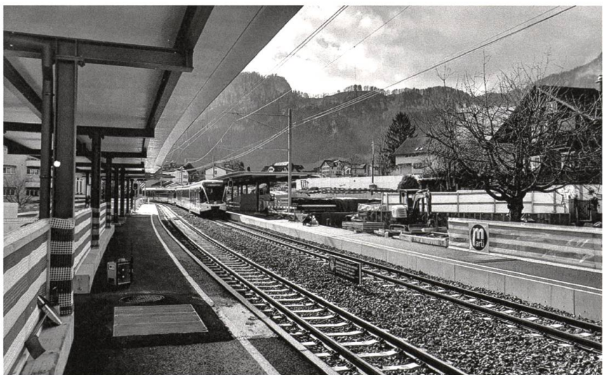
1.3. Inbetriebnahme der modernisierten Haltestelle Hergiswil Matt.
