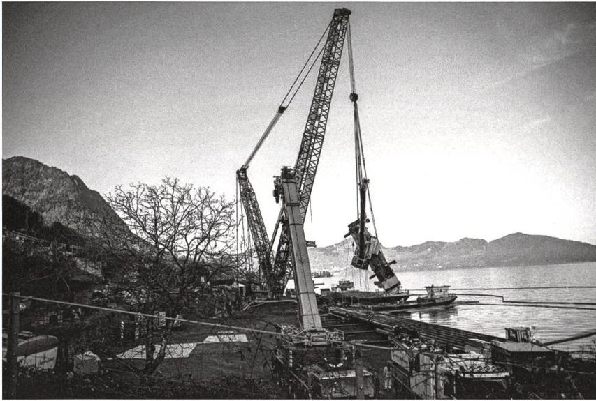
27.1. Bergung des am 15.1. in Beckenried gesunkenen Pneukrans.
