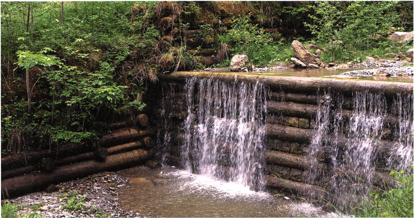
Fällt das Wasser über die Sperre, so verliert es an Energie. Hochwasserschutz am Steinibach.
