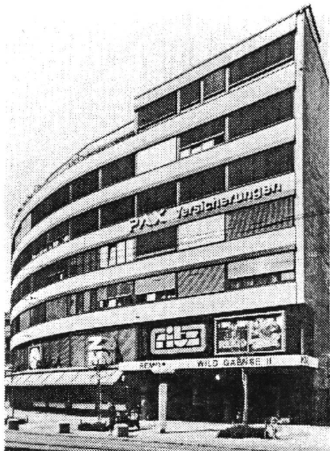
Die renovierte Fassade des "Z-Hauses" in Zürich (Aus "Zürcher Denkmalpflege, 10. Bericht, 2. Teil")
