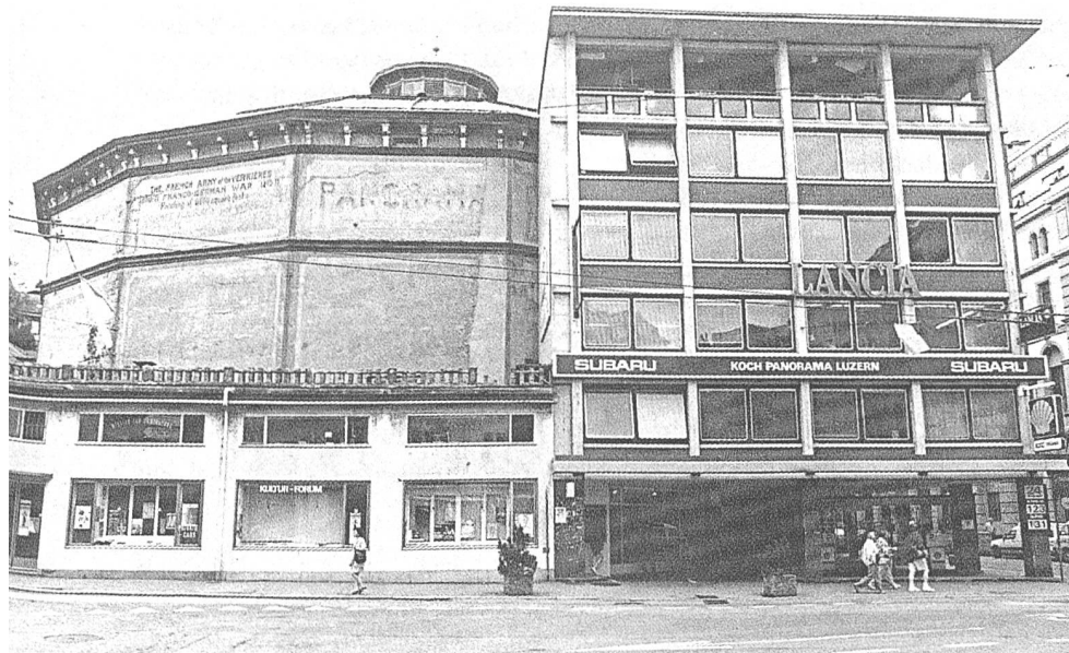
Heutige Ansicht mit Büroeckbau aus den 50er Jahren.
