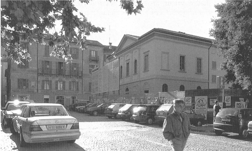
Das Teatro sociale in Bellinzona (Foto: SHS)
