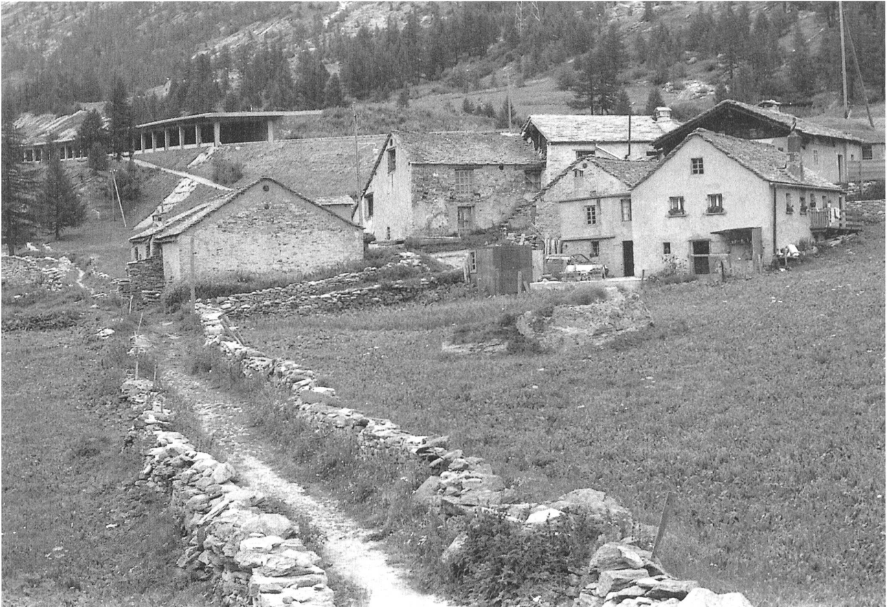
Der Stockalperweg beim Weiler «Maschihuis» (Simplon-Süd) mit originaler gepflasterter Wegoberfläche und seitlichen Begrenzungsmauern.
