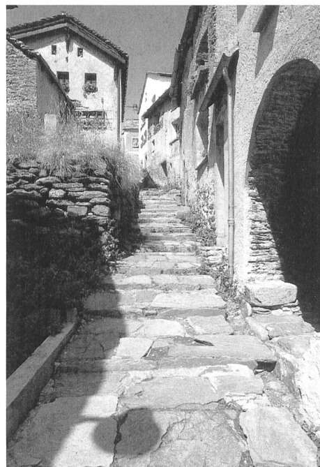
In Simplon-Dorf ist längs des von Süden zum Dorfplatz ansteigenden Saumpfads in der 2. Hälfte des 17. Jahrhunderts und um 1700 ein beachtlicher Baubestand aus Mantelmauerhäusern entstanden. Ihnen verdankt der als «Stutzji» bezeichnete, eindruckliche Gassenzug seine Italianità.
