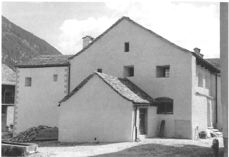
Der «Alte Gasthof» ist das eigentliche Zentrum der Stiftung «Ecomuseum Simplon», ein eindrückliches Sustengebäude auf dem Dorfplatz von Simplon-Dorf. Der zweigeschossige Gebäudekomplex wurde in mehreren Bauetappen (14. bis 18. Jh.) in Mischbauweise errichtet. Die Blockwandteile sind aber in der ortsüblichen Bautradition mit einer Mantelmauer versehen: dadurch erhält der verschachtelte Gebäudekomplex den Habitus eines Massivbaus.
