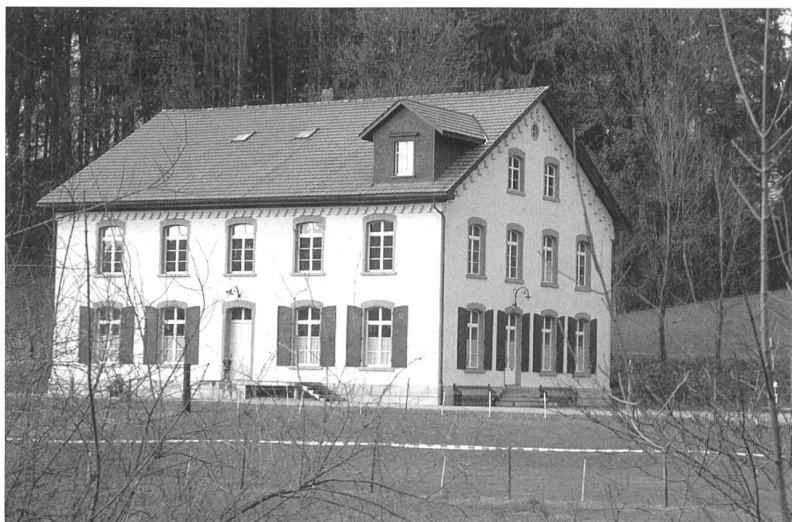
Historische Textilfabrik im Sorntal, erbaut um 1850
