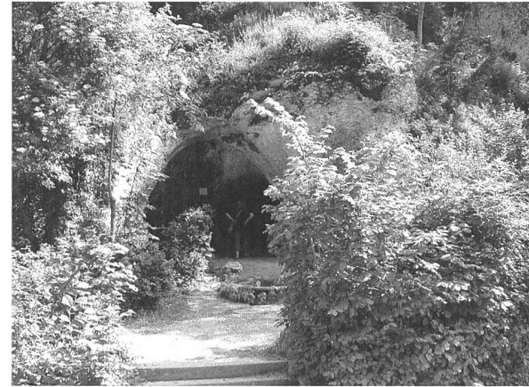
Die heutige Eingangssituation mit dem freigelegten Felsen.
