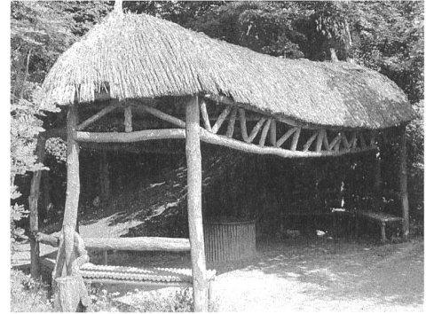
Die heutige Situation mit der neubauten «Urhütte».
