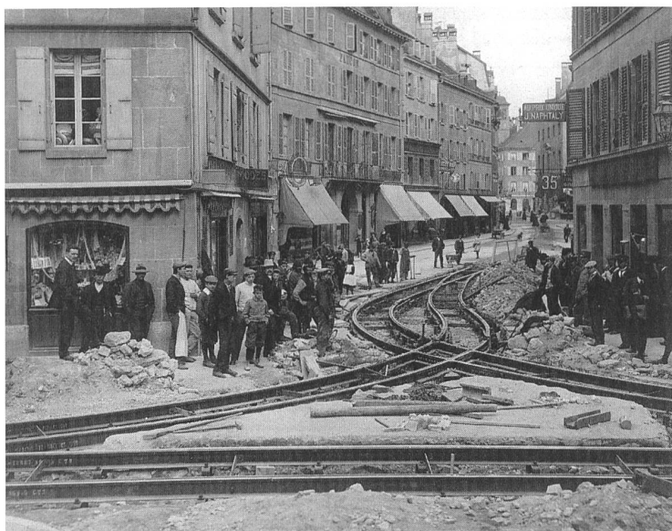
Pose des rails de la boucle des tramways à la rue de l'Hôpital à Neuchâtel, vers 1910.
