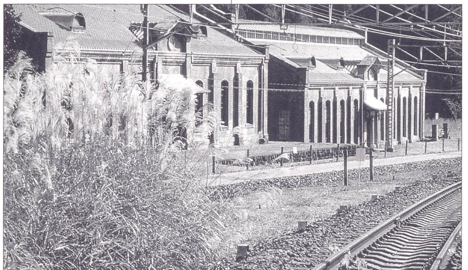
Usui-Toge-Bergstrecke nach der Restaurierung eines Teilstücks mit Wanderweg und renoviertem Umformerwerk.
