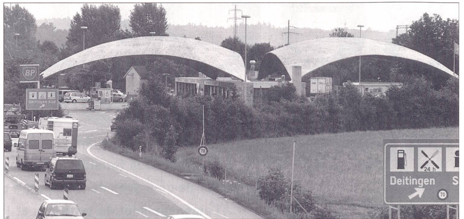
Station-service de Deitingen, Heinz Isler, 1964–66. Les deux voiles de béton fonctionnent comme repère à l'échelle du territoire et de la vitesse de déplacement.
