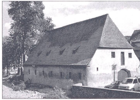
Mit Kalkmörtel verputzte Bauten wie dieses Ökonomiegebäude in Cesky Krumlow trockneten ohne Schäden aus.
