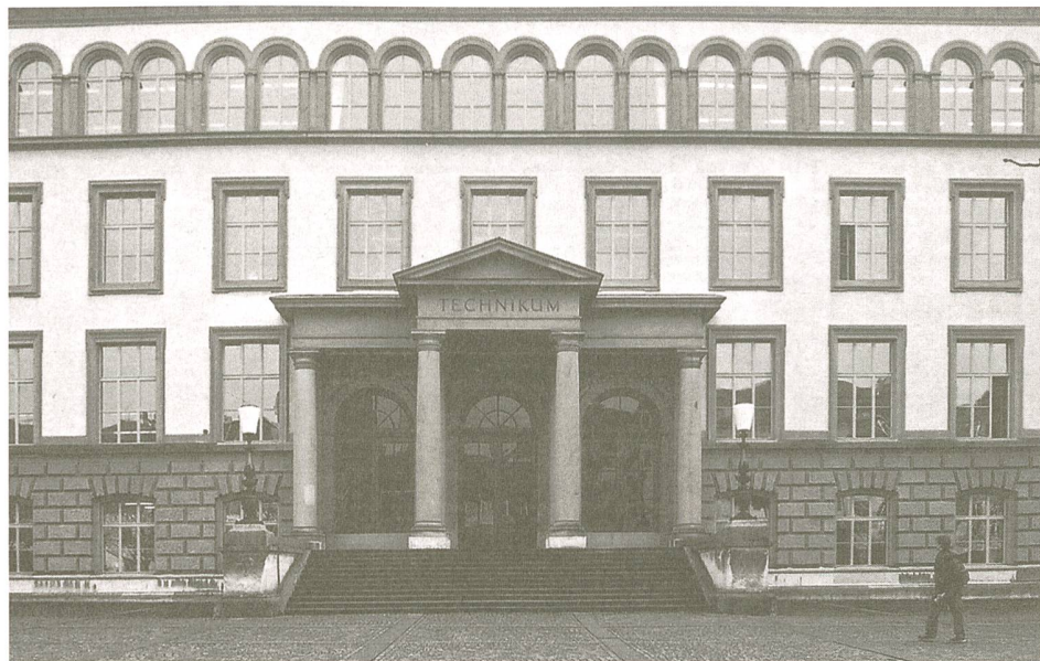
Winterthur, Schulhaus Technikum 1873/74; Fenster mit Doppelverglasung aus den 1930er-Jahren, Auswechslung der inneren Einfachverglasung.
