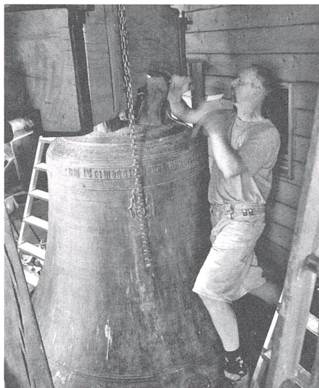
Cloche no 2. Retouches de l'ébéniste pour ajuster le joug sur la cloche lors de l'opération de suspension.
