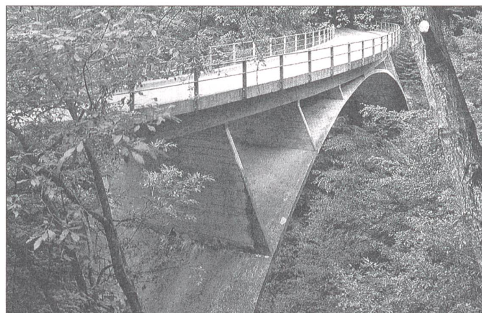
Ein Meisterwerk aus Eisenbeton: Die von Robert Maillart 1933 konstruierte Schwandbachbrücke.
