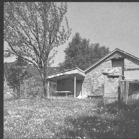
Monti di Medeglia. Una stalla-fienile trasformata in casa di vacanza con l'aggiunta di corpi e materiali estranei.
