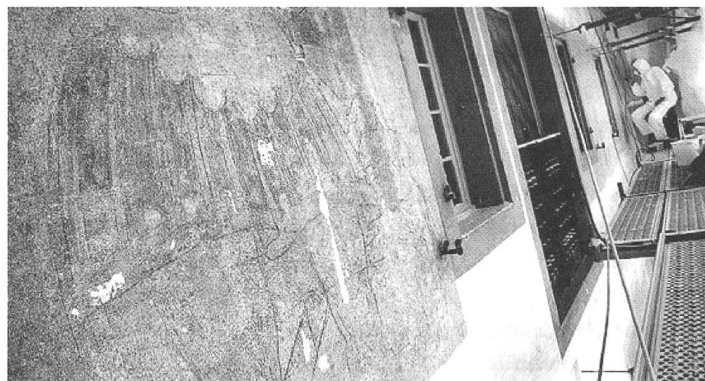
Schloss Büren an der Aare: Im oberen Bereich der Fassade konnte eine detailreiche Malerei wiedergewonnen werden.
