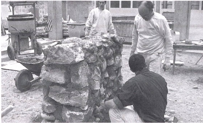
Der Lehrgang «Handwerk + Denkmalpflege» vermittelt Kenntnisse für den Umgang mit Altbausubstanz.
