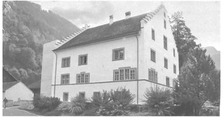
Suworow-Haus: Respektvoller Umgang mit der originalen Bausubstanz.
