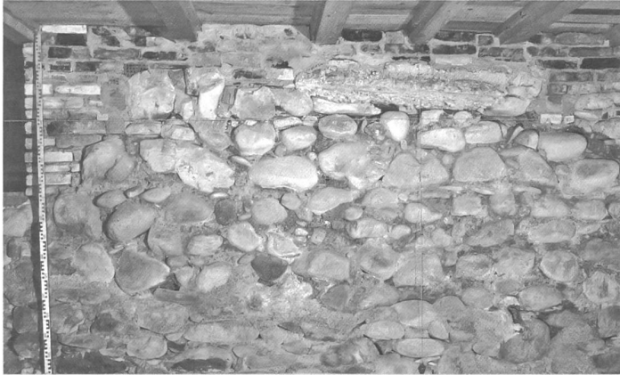
Die Ringmauer einer Burg? Im Keller des Grossen Höchhus findet sich Mauerwerk aus dem 13. Jahrhundert.
