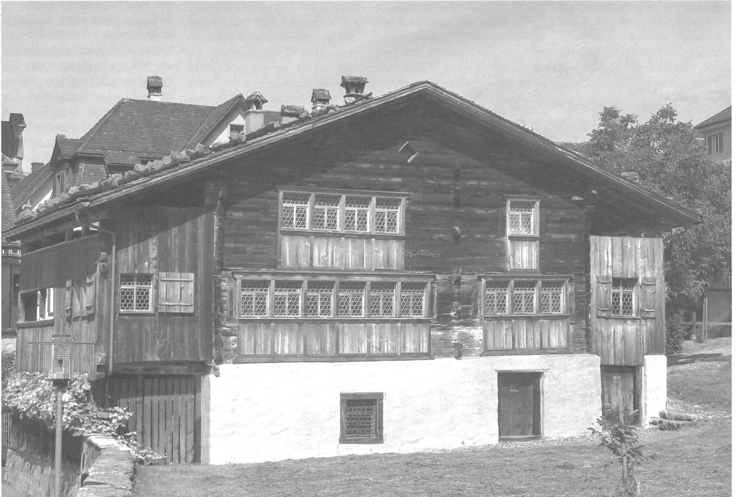
Schwyz, Haus Bethlehem, um 1287 errichtet. Die Fensteröffnungen mit Zugladeneinrichtungen sowie die verschalten Lauben stammen aus dem 18. Jahrhundert.
