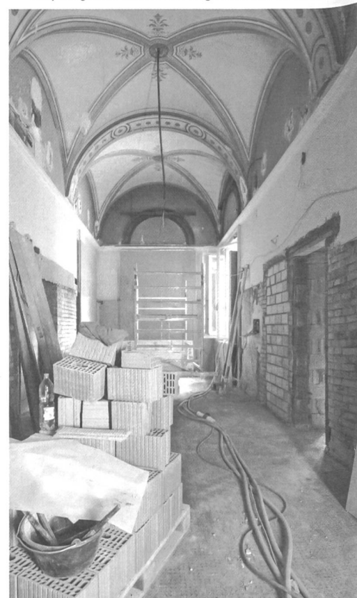
4) In der Ständerats-Garderobe: Nach Entfernen der eingehängten Decke erscheint die ursprüngliche Decke mit originaler Dekoration.
