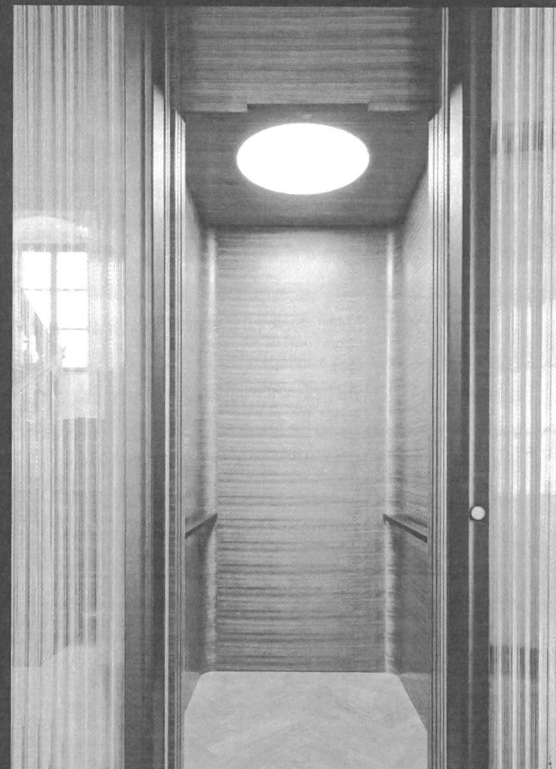
Die Liftkabine ist innen und aussen mit dem im Rathaus allgegenwärtigen Nussbaumholz verkleidet. Schlanke Glasstäbe schirmen den Blick in den Liftschacht ab.
