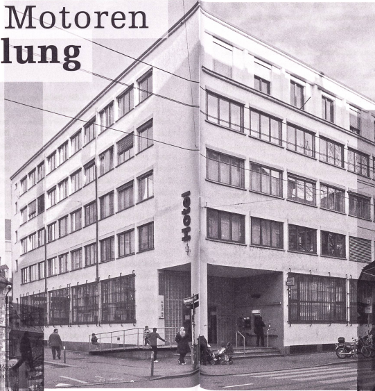
Frühes Beispiel des Neuen Bauens: Das Limmathaus in Zürich.
