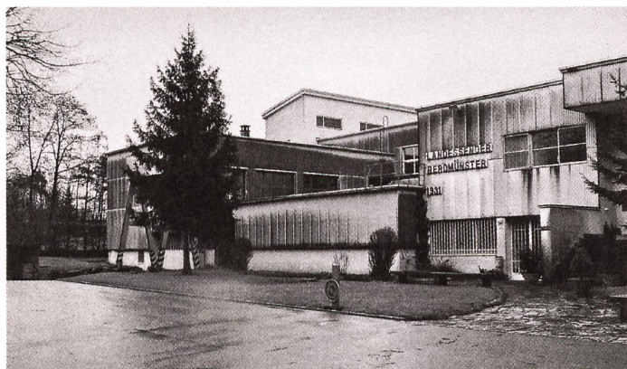
2007 bildeten Denkmäler der Technikgeschichte einen Schwerpunkt der Gutachten der EKD: Das Sendegeäude des legendären Mittelwellen-Landessenders Beromünster (LU).
