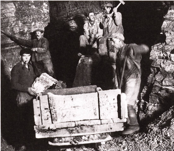
Die letzten Stollenarbeiter: Bis 1944 wurde noch Gips für die Zementindustrie abgebaut.
