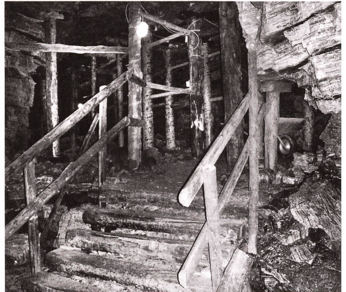
In der Gipsschicht werden die Stollen höher und breiter. Durch das herabgestürzte Gipsgestein nach der Einstellung des Gipsabbaus gibt es heute unterschiedliche Niveauhöhen.
