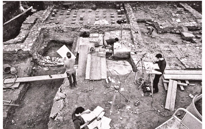
Die Badeanlage vom Eingangsbereich her gesehen: Im Hintergrund die Plattenpfeiler im Beheizungszwischenraum einer Fussbodenheizung.
