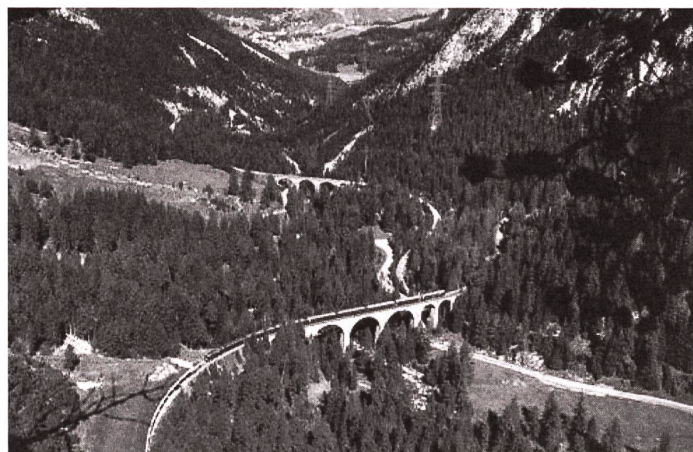
Reich an Brückenbauten: Die Albulabahn zwischen Bergün und Preda.
