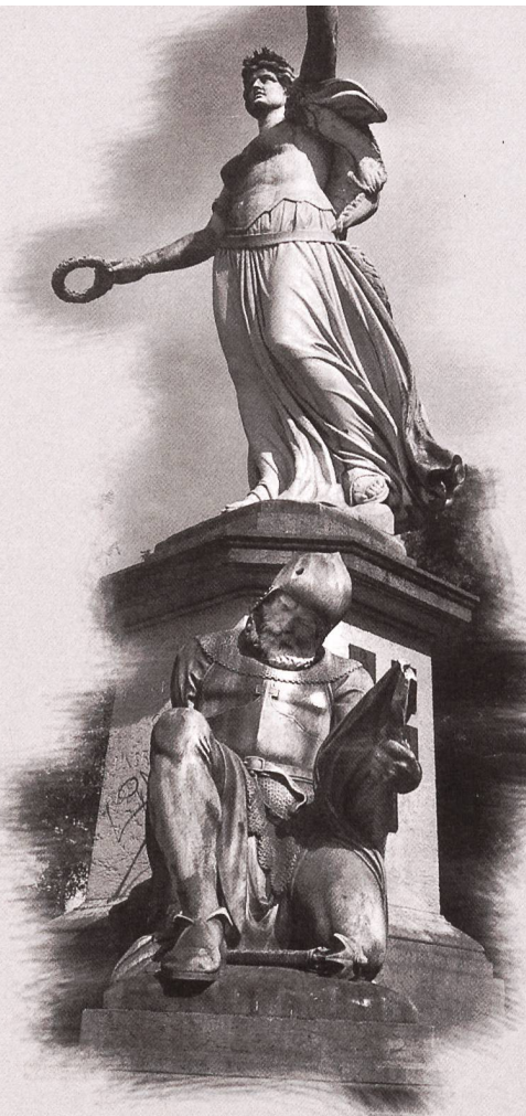
Das St. Jakobs-Denkmal in Basel: Verschiedenste Verschmutzungsarten erfordern ein differenziertes Reinigungskonzept.
