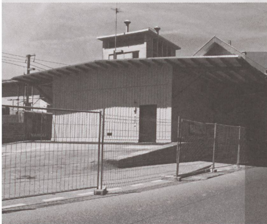
Der Güterschuppen von Steinhausen ZG wurde erhalten und für 2009 die Bahntechnik umgenutzt (Einbau einer elektronischen Stellwerkanlage).
