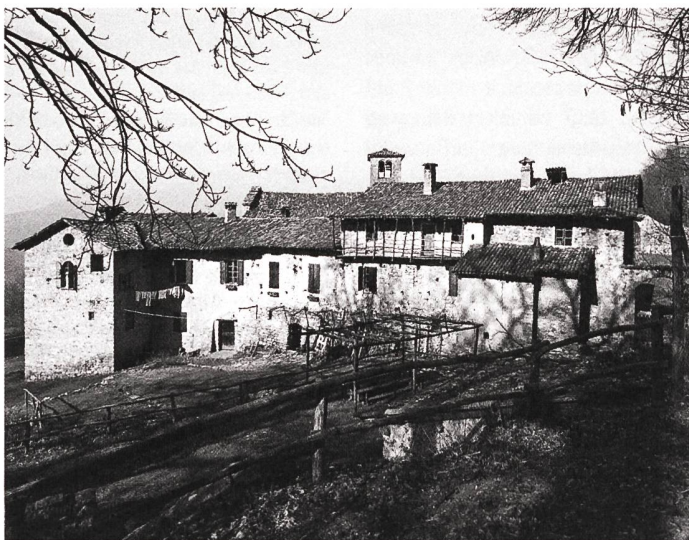
Beispiele von Ortsbildaufnahmen, wie sie in den ISOS-Bänden publiziert sind: Tollelo TI,...
