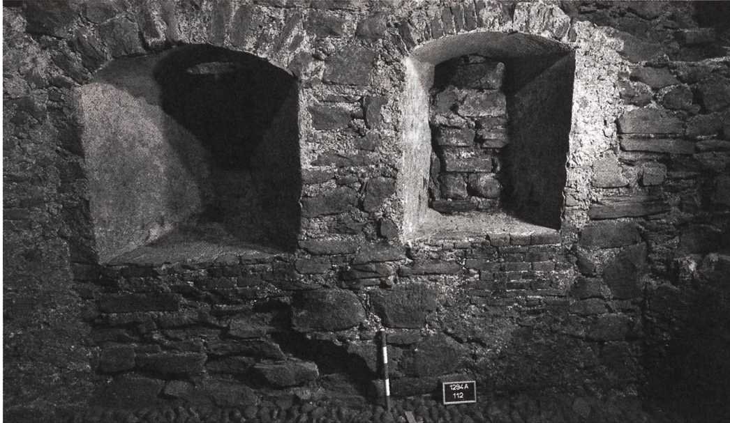
Blick auf die beiden Schartenfenster in der ehemaligen Stadtmauer von Willisau.
