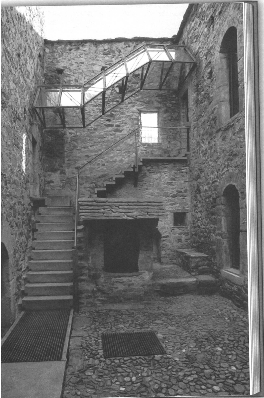
Bellinzona, Castello Montebello. Blick in den Innenhof. Zustand nach der Umgestaltung von 1974/75 zum Museo Civico.
