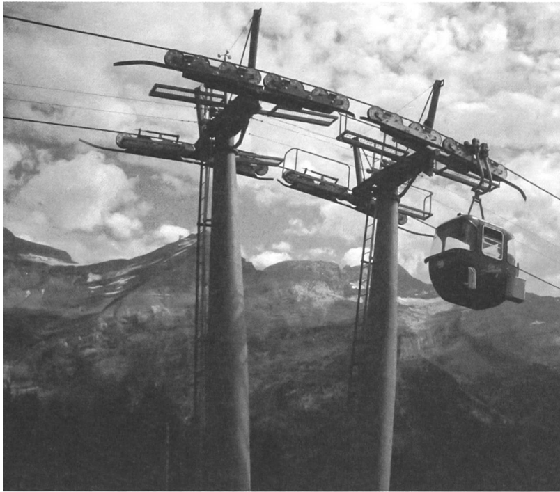
Einseil-Umlaufkabinenbahn Les Diablerets-Isenau, Les Diablerets (VS), von Giovanola Frères (1974). Stűtze und Fahrzeug.
