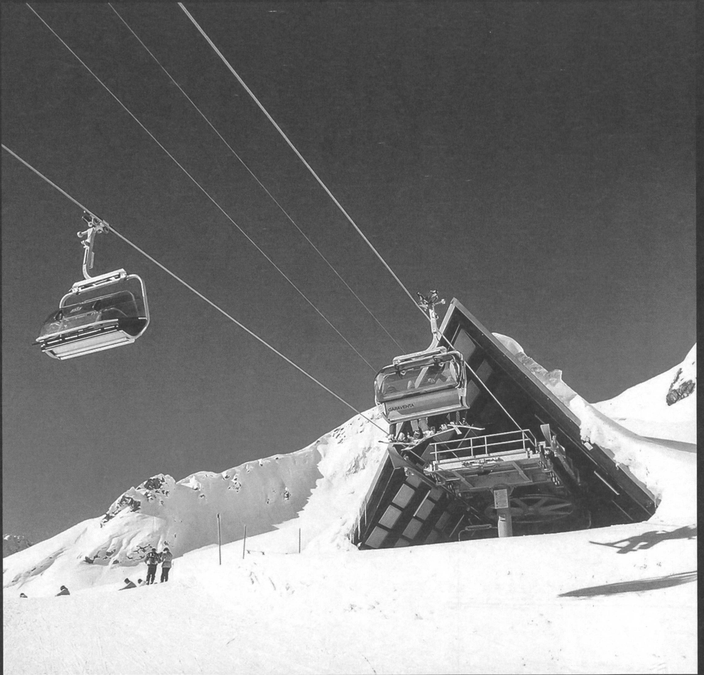
Bearth & Deplazes: Carmenna-Sesselbahn, Bergstation.
