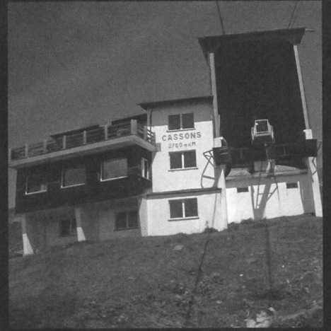
Bergstation der Pendelbahn Alp Naraus-Fil da Cassons.
