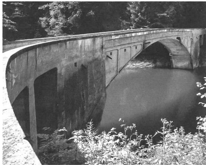
Schrähbachbrücke bei Innerthal im Wägital (SZ), 1924 von Robert Maillart erbaut; die vermutlich weltweit älteste noch erhaltene Brücke mit versteiftem Stabbogen.
