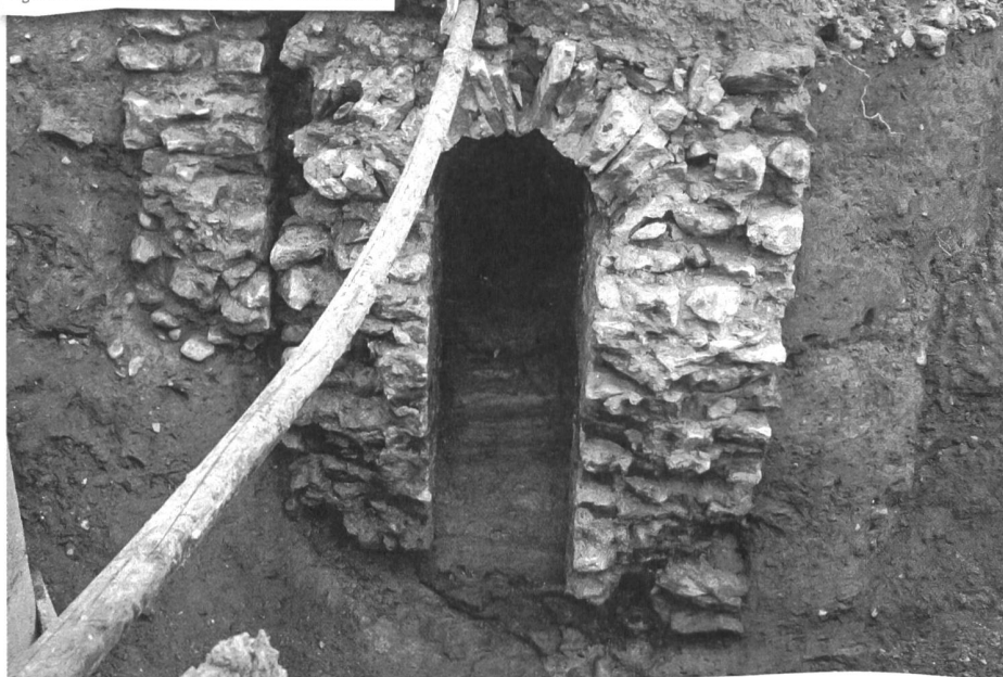
Fig. B: Vue en coupe d'un des principaux égouts-collecteurs de la ville d'Aventicum.
