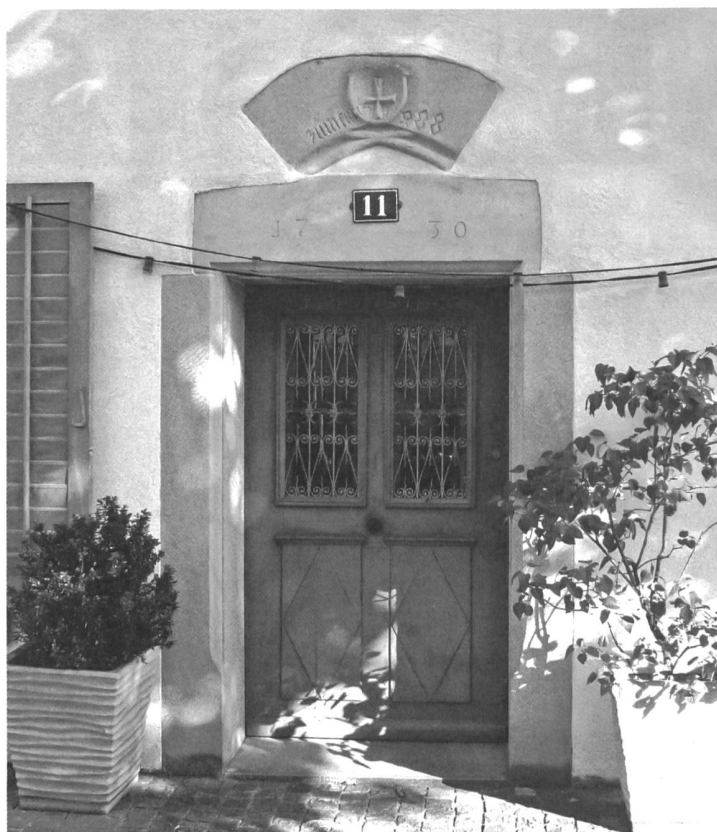
Fragment eines Sandsteinportals von 1488, wiederverwendet als Entlastungsbogen über dem Türsturz von 1730. Zug, Oswaldgasse 11.
