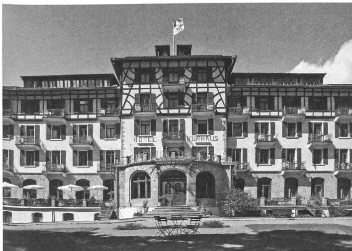
Dank ausbleibendem wirtschaftlichen Erfolg blieb das Jugendstilhaus samt Ausstattung weitgehend original erhalten. Nun ist das Kurhaus Bergün (GR) Historisches Hotel des Jahres 2012.
