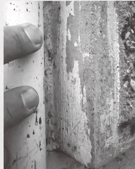
An witterungsgeschützten Stellen des Monuments am Hafen Enge sind noch Rückstände der weissen Schlämme/Anstrichs erkennbar.
