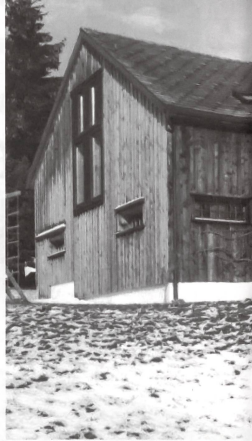
Geschickte Neunutzung des Scheunenteils bei einem Bauernhaus in Wildhaus (SG) ohne merklichen Substanzverlust und störende Eingriffe in das Erscheinungsbild.
