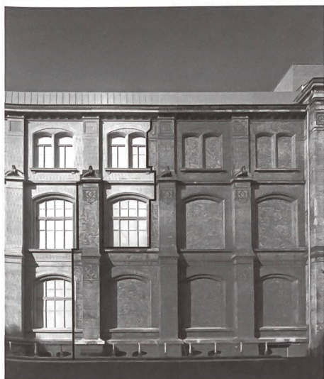
Der Ostflügel des Naturkundemuseums in Berlin. Die Linie markiert den Anschluss der Betonelemente (links) an die noch bestehende Gebäudehülle.
