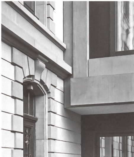
Anschluss des neuen an den historischen Gebäudeteil.
