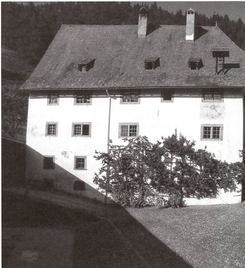
Wärmespeicher: Die Südwand des Hauses speichert die Sonnenwärme und gibt sie in der Übergangszeit nach innen ab.
